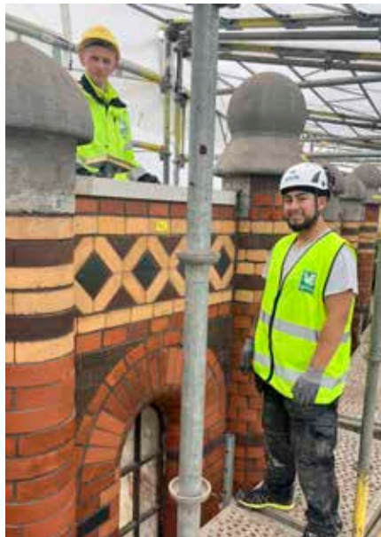
Fasader och dekorativa inslag renoveras omsorgsfullt av skickliga hantverkare.
