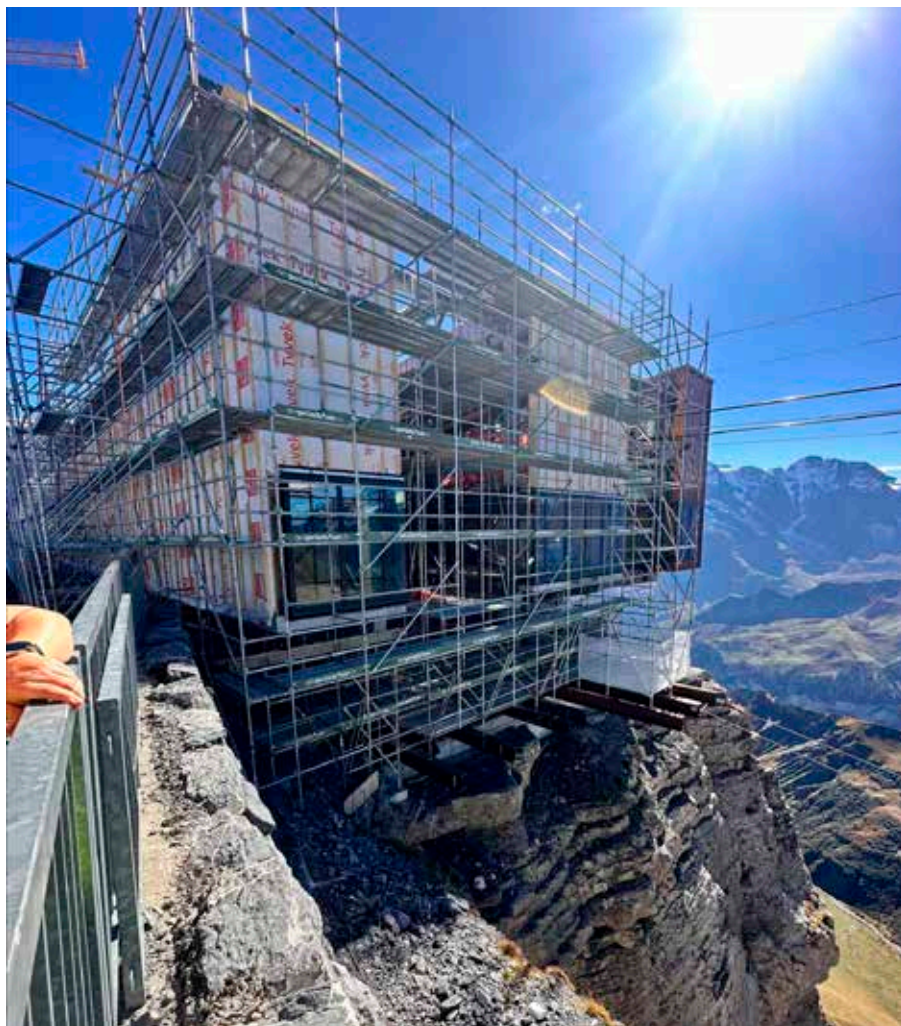
Byggställningar vid världens brantaste linbana i Schweiz.
