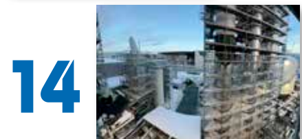
Foto: Jiaob Ställningsmontage AB
