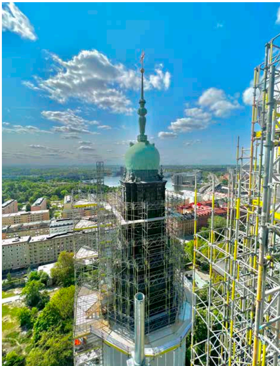
De imponerande byggnadsställningarna vid ett av tornspirorna till Högalidskyrkan i Stockholm.
