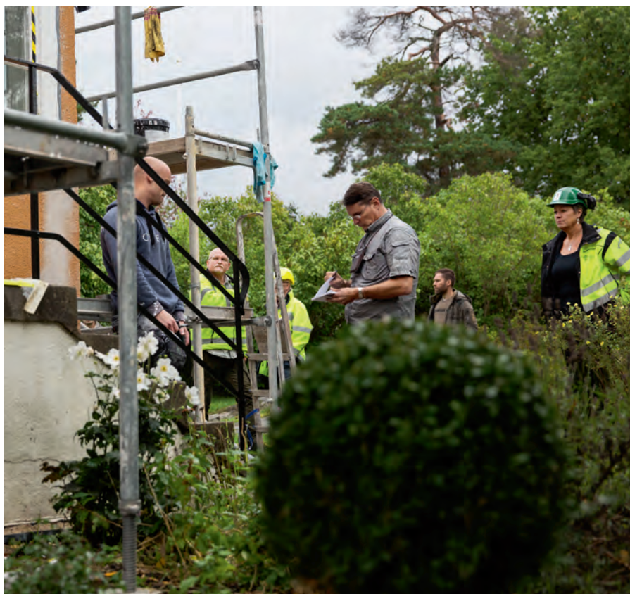
”Hittills har nästan inga byggarbetsplatser klarat sig” säger Mikael Roos, inspektör på Arbetsmiljöverket.
