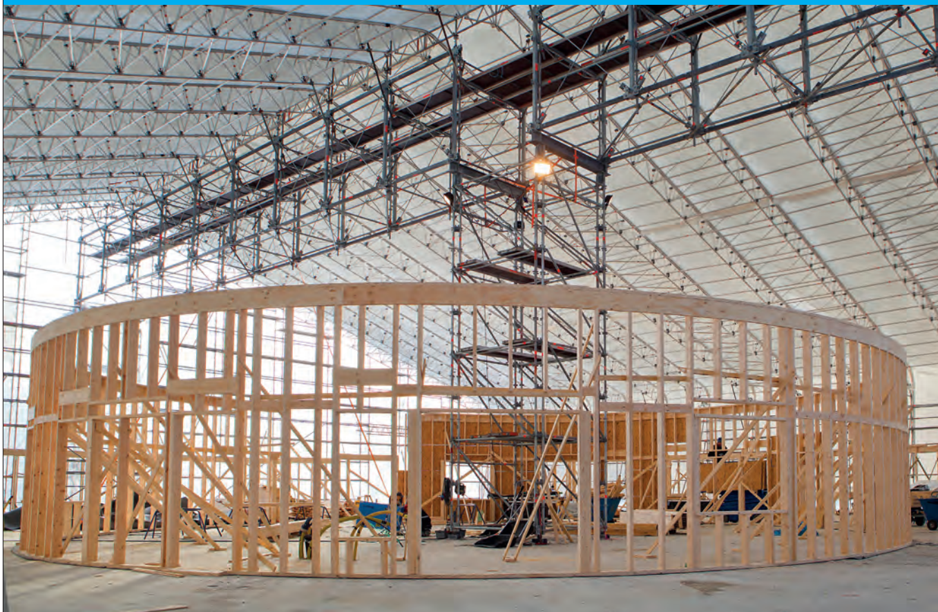
Fuktsäker produktion av passivhus med trästomme.
