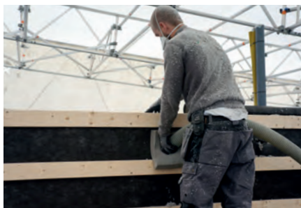
Isolering av trähus under torra förhållanden
