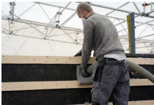
Isolering av trähus under torra förhållanden
