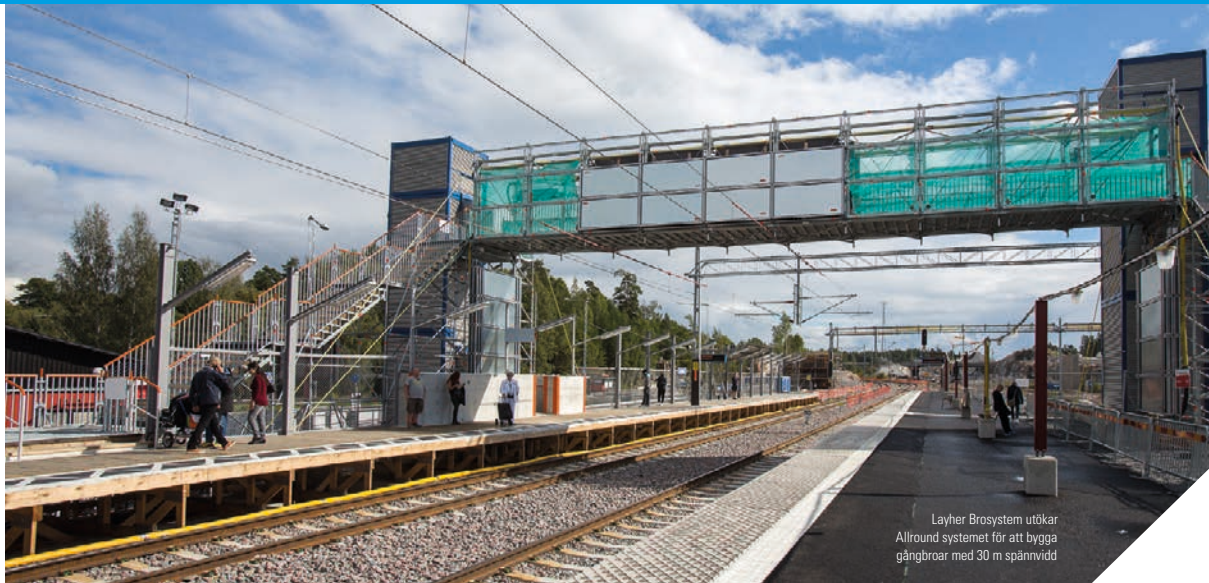
Det modulära trappornet byggs i 2 meter höga sektioner som staplas med kran.
