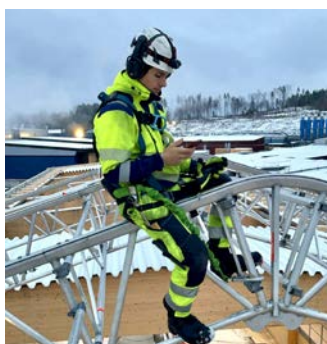
Jag älskar dynamiken och att inget ställe är det andra likt. Ena dagen bygger du en hög fasadställning, och nästa dag arbetar du med speciallösningar inne i en industri.
